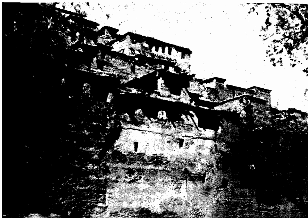
FIG. 19. — L' izji chez les Igounan forme de véritables loggia, primitivement carrées, aujourd'hui en forme d'arcades (celles du haut). Les murs extérieurs des maisons, jointifs et dépourvus de porte, font au village une enceinte continue. (Cliché de l'auteur.)
