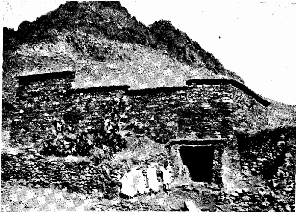
FIG. 16. — Maison de pierre sèche dans un village des Ighchen . On remarque, à gauche de la porte, l'espèce d'enclos rempli de terre qui sert de contrefort au mur de la maison ( ilmedeffes ). (Cliché de l'auteur.)
