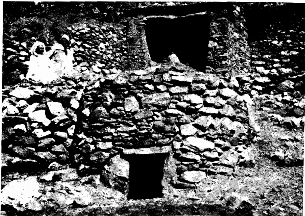
FIG. 17. — Maison de pierre sèche. Devant la porte, entrée d'un abri souterrain pour
